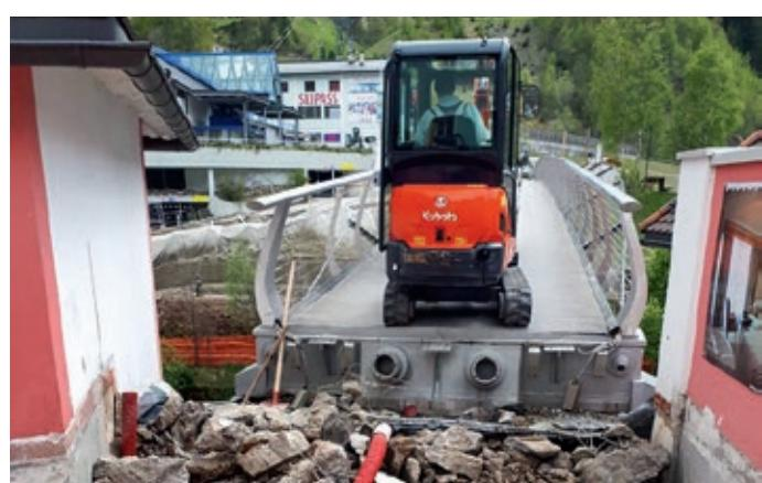
Il ponte pedonale Setil è stato ristrutturato. Sono state sostituite parti arrugginite. Inoltre sono stati rifatti i blocchi di cemento di collegamento al ponte. È stato necessario rifare anche la coibentazione.
